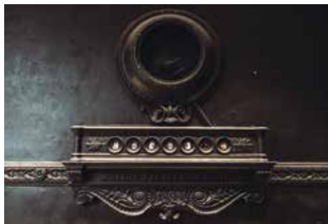
Fragment zachowanej instalacji
