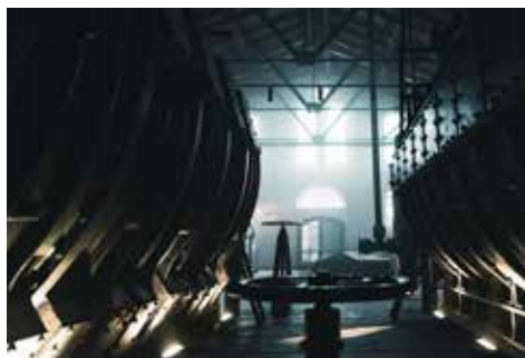
Fragment zachowanej instalacji
