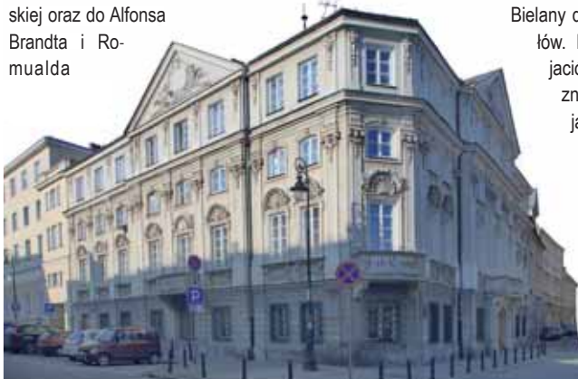
Pałac Wesslów Warszawa
